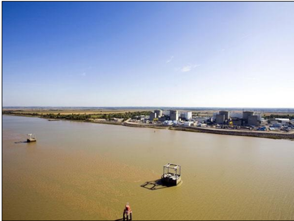
Figure 14. Vue depuis l'estuaire sur la CNPE du Blayais et prises d'eau amont et aval (source : energie.edf.com)
