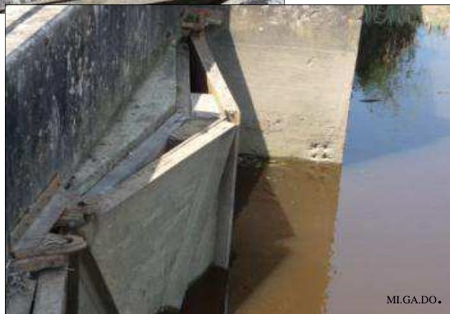
« Raidisseur ») pour ralentir la fermeture des ouvrages et permettre une gestion adaptée aux saisons et aux besoins
