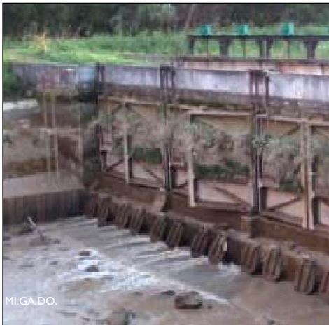
Des clapets à axe horizontal
