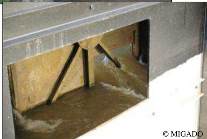
Vanne télescopique permettant de garder un niveau défini dans le marais amont
