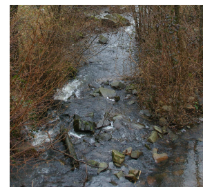
Photo 20 : Démantèlement d'un seuil.
