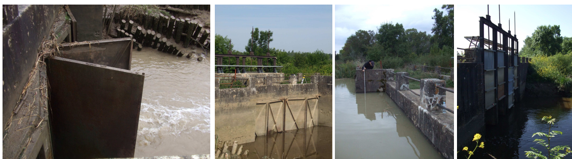
Photo 48 : Les portes à flots du marais d'Arcins-Soussans ouvertes et fermées en fonction du niveau d'eau aval et les vannes associées. Source : MIGA.DO.
